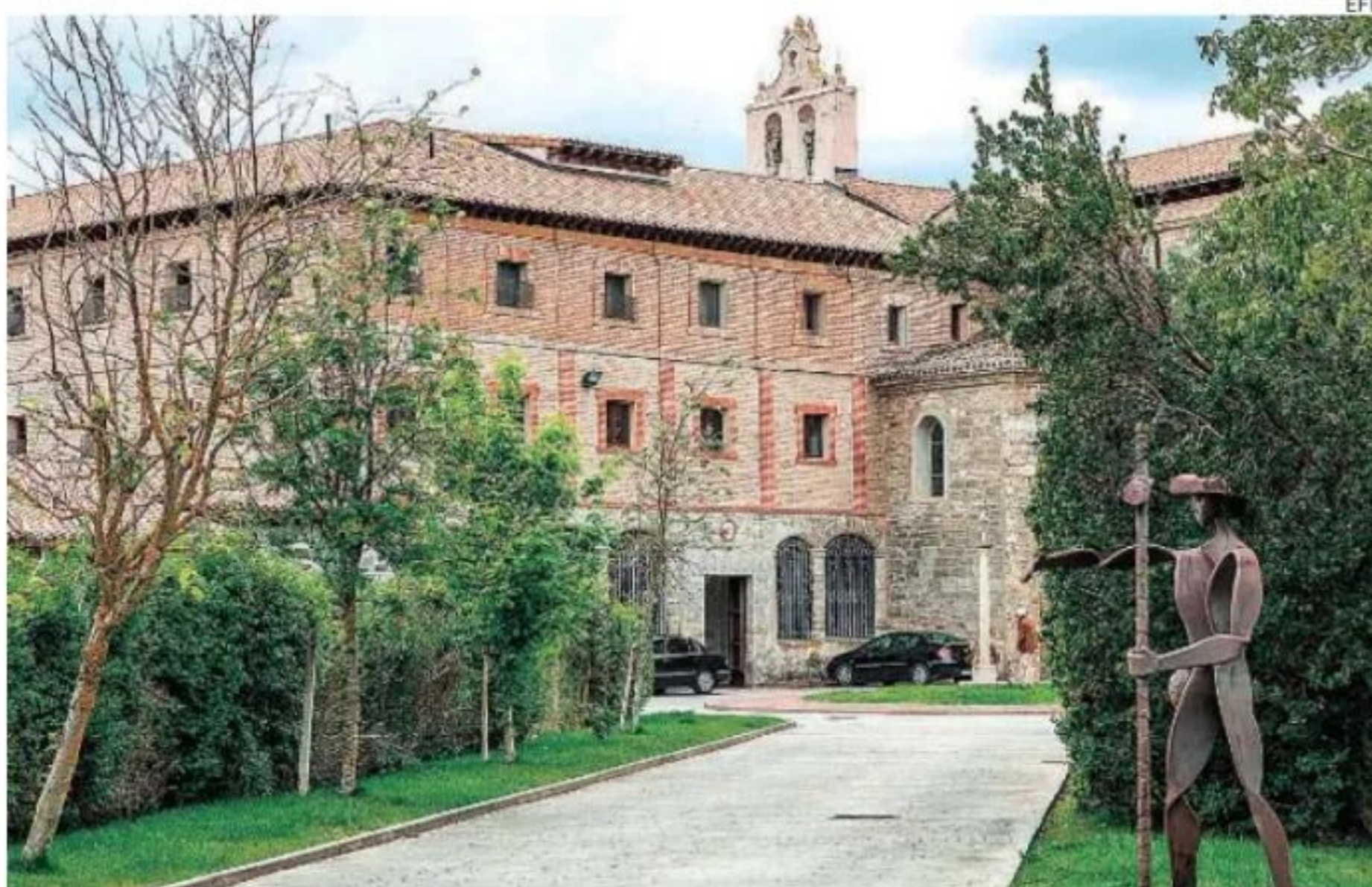
Imagen de la fachada del convento de Belorado (Burgos)
